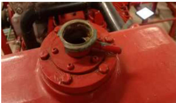
รูปที่ 13 ตรวจสอบระดับหม้อน้ำ
