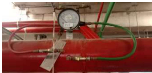
รูปที่ 16 ตรวจสอบเช็คสภาพสายแรงดันลม
