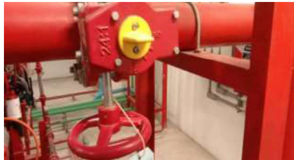
รูปที่ 15 ตรวจสอบเช็ควาล์ว ปิด/เปิด น้ำ
