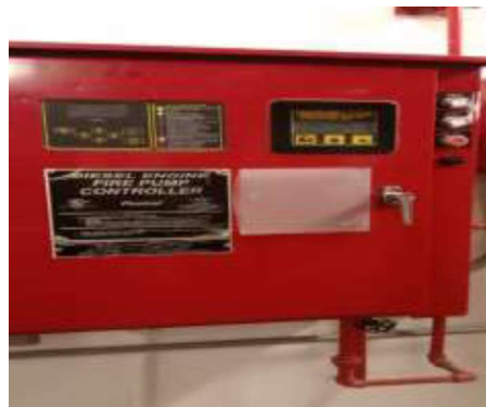
รูปที่ 1 ตรวจเช็คตู้คอนโทรลระบบปั๊มแรงดันสูง
